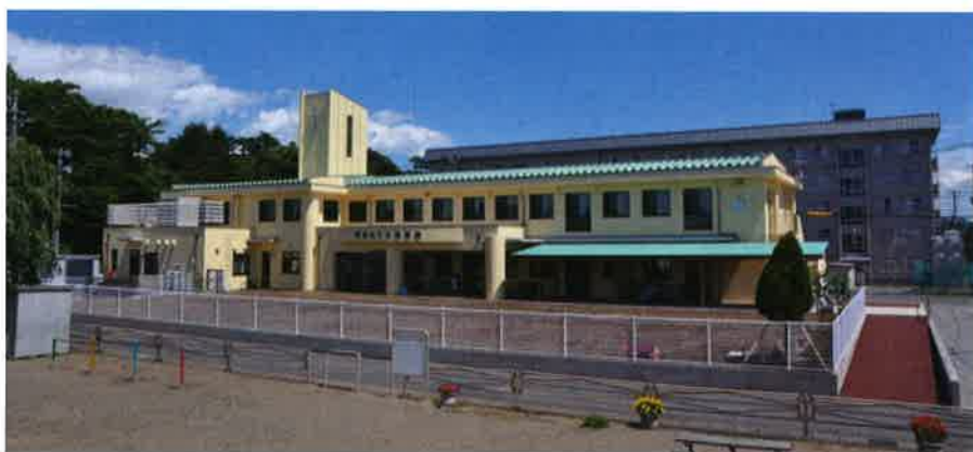
園舎正面に新しい園庭が完成
